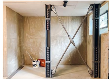
Die Hegibachstrasse 54, 56, 58 muss gegen Erdbeben ausgesteift werden. Foto Stiftung PWG
