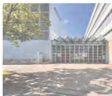
bb. UBS Rechenzentrum Altstetten. Neuplanungen vorhanden, Rückbau in naher Zukunft.
