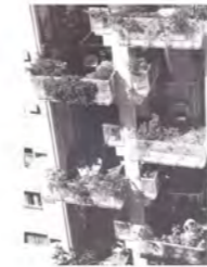
Clorindo Testa: Edificio Rodríguez Peña 2043, 1975
