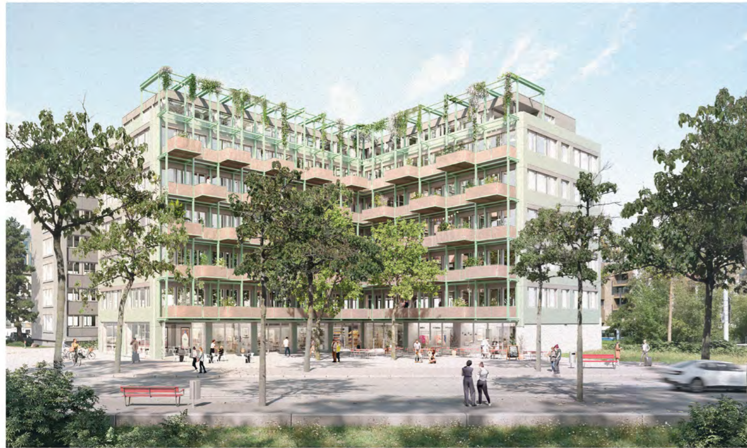
Die Fassade am belebten Quartiersplatz erhält ein neues Gesicht.
