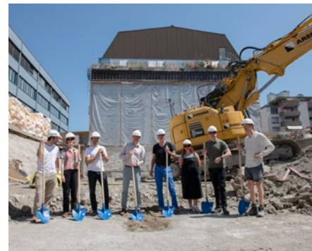
Der Grundstein für das Gewerbegebäude an der Flüelastrasse 16 ist gelegt. Foto Mirjam Graf
