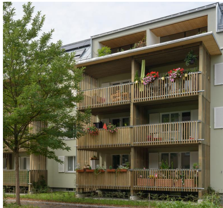
Saumackerstrasse 76, 78, 80; Gesamtsanierung und Aufstockung (+ 6 Wohnungen) im Jahr 2015.
