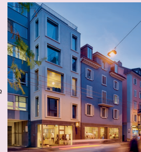
Gesamterneuerung und Ergänzungsneubau Militärstrasse 115, Zürich-Aussersihl, 2013 Baulücke geschlossen und innovativen Wohnraum für Junge geschaffen.
