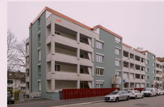
Sanierung Gebäudehülle und Aufstockung Saumackerstrasse 76, 78, 80, Zürich-Altstetten, 2015 Ein zusätzliches Geschoss, wärmegeklämt und Minergie-zertifiziert.
