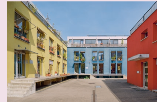
Ersatzneubau Freihofstrasse 32, 34, Zürich-Altstetten, 2019 Kompakte Grundrisse und dank Mobilitätskonzept ohne Tiefgarage.
