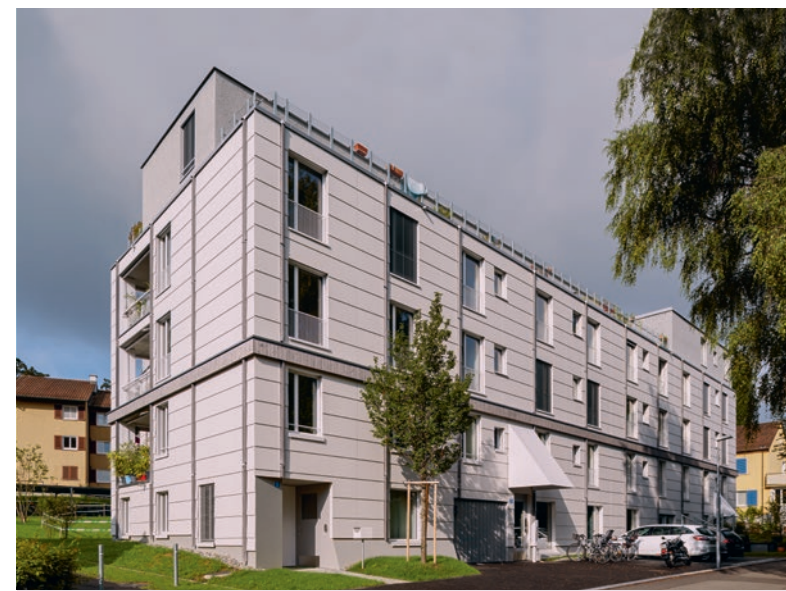
Ersatzneubau Waldmeisterweg 3, 5, Zürich-Unterstrass, 2018 Beispielhaftes Gebäude mit neu 21 Wohnungen (vorher 8) zur gestaffelten Verdichtung einer Parzelle (Architekturpreis Kanton Zürich 2019).
