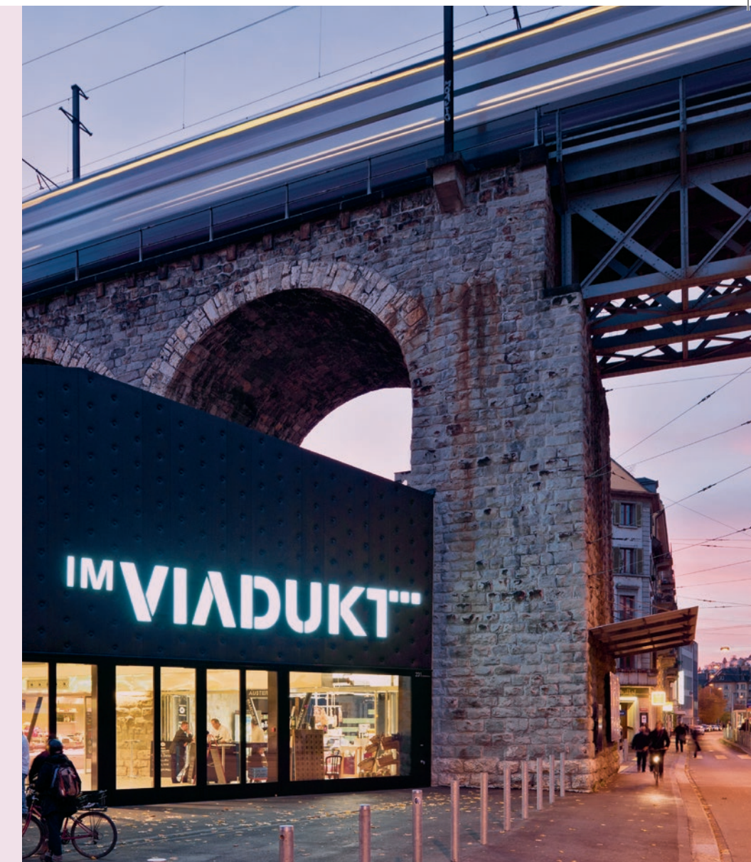
Projektentwicklung und Umnutzung IM VIADUKT, Zürich-Industriequartier, 2010 Von der trennenden Barriere zum verbindenden Element im Kreis 5.
