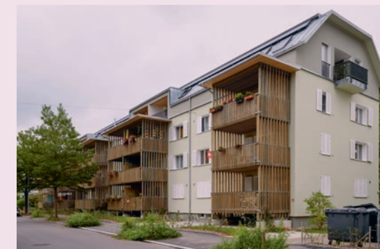
Sanierung Gebäudehülle und Aufstockung Saumackerstrasse 76, 78, 80, Zürich-Altstetten, 2015 Ein zusätzliches Geschoss, wärmegeklämt und Minergie-zertifiziert.
