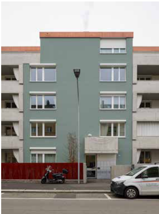
Vom schweren Vordach des Hauseingangs scheint – beschwert von einer Betonkugel – ein Leintuch zu hängen. Die augenzwinkernde Gestaltung stammt von Christian Hörler.
