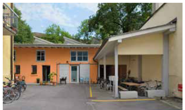
Der ehemalige Pferdeunterstand wurde zu einem Abstellplatz für Velos und einem Arbeits- und Aufenthaltsraum für alle Mietenden.
