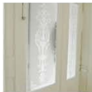
bestehende Türen werden aufgedoppelt, ganze Front EI 30
